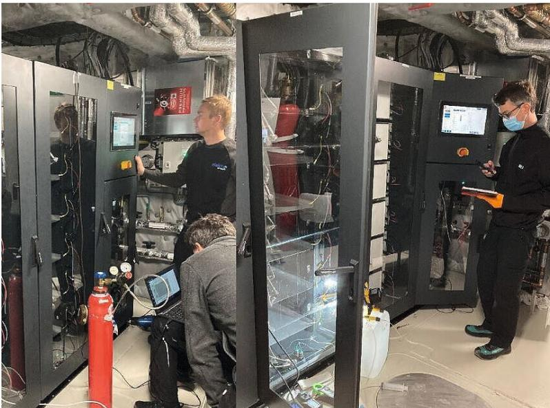
*Brennstoffzellen-Schrank. Quelle: Meyer Werft GmbH & Co. KG*
