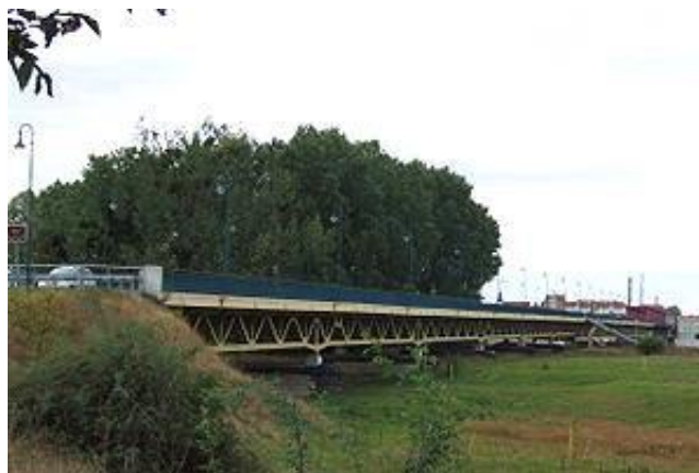
Abb. 28: Alte Elbbrücke in Schönebeck
