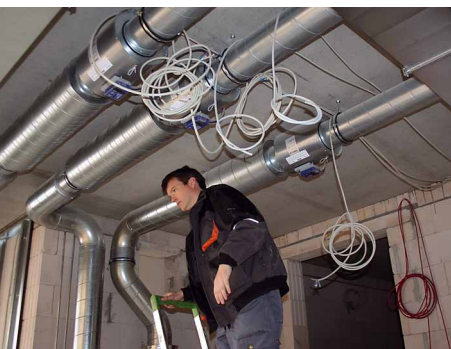
Überprüfung des Einbaus der Volumenstrom- regler für die Belüftung der Klassenräume / Testing installation of volume flow controllers for classroom ventilation
