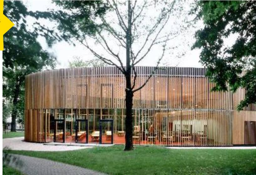
Neubau Casino mit Speisesaal und Cafeteria in Bonn
