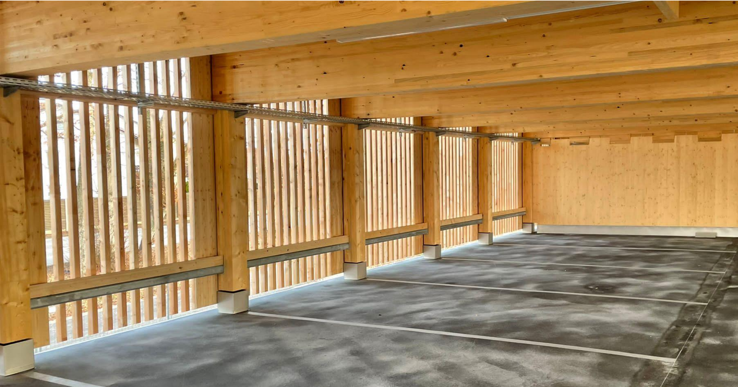
INNENANSICHT OG (BILDRECHT EDER HOLZBAU)
